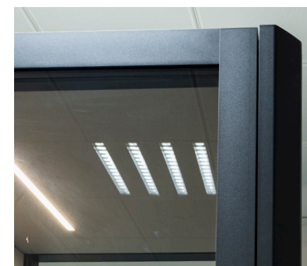
Acoustique VERRE Butyral 4+4 mm Akustik-GLAS Butyral 4+4 mm
